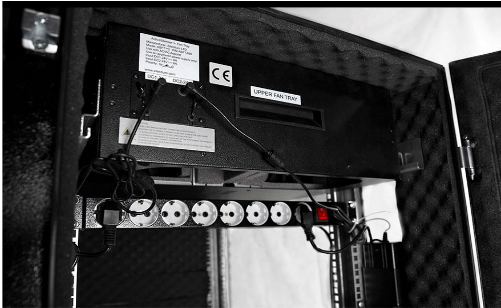
Рис 3. Шумоизоляция серверного шкафа https://tsi-auto.ru/news/kak-sdelat-shumoizolyatsiyu-servernogo-shkafa-ili-majning-fermy
